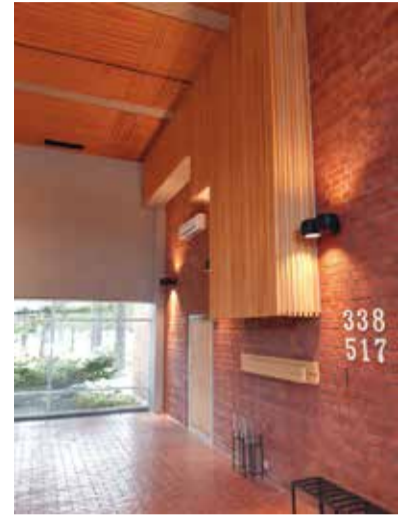
Siunauskappeliin tuli kaunis puupaneeli putkiston päälle.
